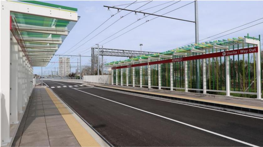
Le banchine per 15 fermate intermedie e due capolinea sono lunghe 28 m ed alte 30 cm. L'infrastruttura è predisposta per potere accogliere i filobus 24 m «high capacity»
