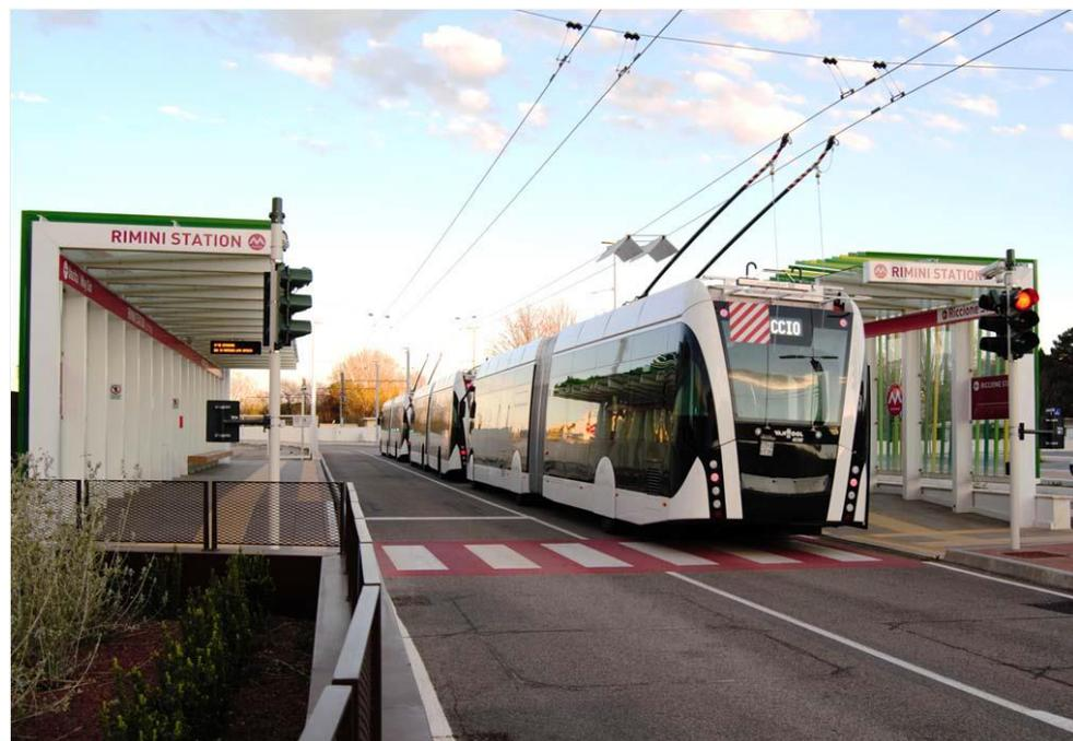
La corsia è interamente riservata ed in sede propria. Ha una lunghezza di 9,8 Km, parzialmente a doppia via di corsa (sezione 7,30 m) e parzialmente a singola via (sezione 4,2 m).
